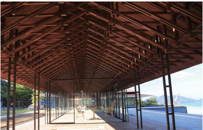
リゾートホテル ペラピスタ境ガ浜 レストラン棟 設計:株式会社NAP建築設計事務所/株式会社山田憲明構造設計事務所 所在地:広島県尾道市 木質構造部材:製材品 施工:大和建設株式会社 木質構造部材:製材品、構造用合板 使用樹種:地場産アカマツ、針葉樹、ラワン 使用量(材積):21.49㎡ 延床面積:950.86㎡、119㎡(鉄骨造地上1階建て) コメント/細部材をトラス形状に組み合わせ、梁間×桁方向の空間へ74フレーム並べた。主要フレームの接合部には金物と木造古来の組子技術を採用。
