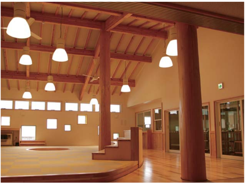
ながと保育園 所在地:長野県小県郡長和町 木質構造部材:集成材 使用樹種:地場産カラマツ 使用金物:プレセッターSU 延床面積:1662㎡ コメント/広くて大きな空間を立体トラスで実現。地域産材を使用し自然に親しむ町のランドマーク。
