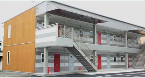
藤田建設工業株式会社社員寮(1時間準耐火鉄骨造2階建て)
