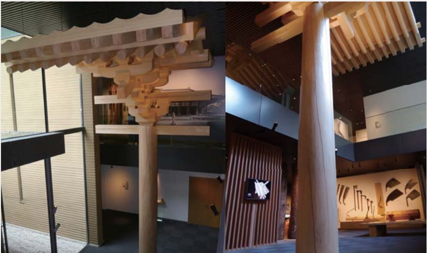
地下1階～2階の吹き抜けに設置された唐招提寺金堂組物の実物大模型。木造建築の迫力に圧倒されます
