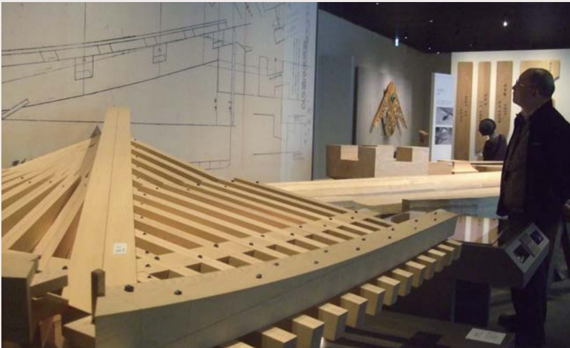
「大工と雀は軒で泣く」といわれるほど、大工の苦労どころといわれる屋根の軒廻り箇所 の模型
