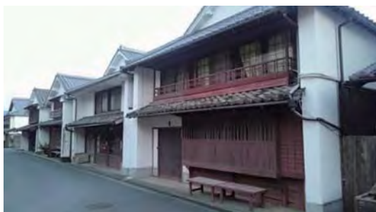
図15 漆喰の防火壁（うだつ）が厚板面材CLTによる木造防火壁に置き換えられた町並み
