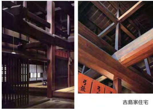
図6 吉島家住宅の柱梁に見る線材の用いられ方
