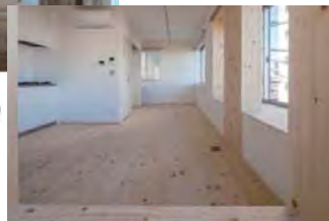
耐火構造（被覆型） 赤羽の集合住宅（2015） 設計：KUS+team Timberize
