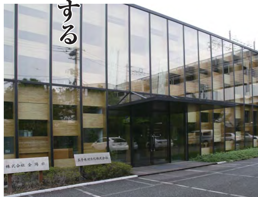
内部の木質部材が、ガラス張りの前面壁を透して見える瀟洒なつくりの社屋。
