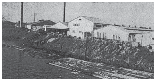
千住プライウッド株式会社 埼玉塗装工場・合板工場 ※2
