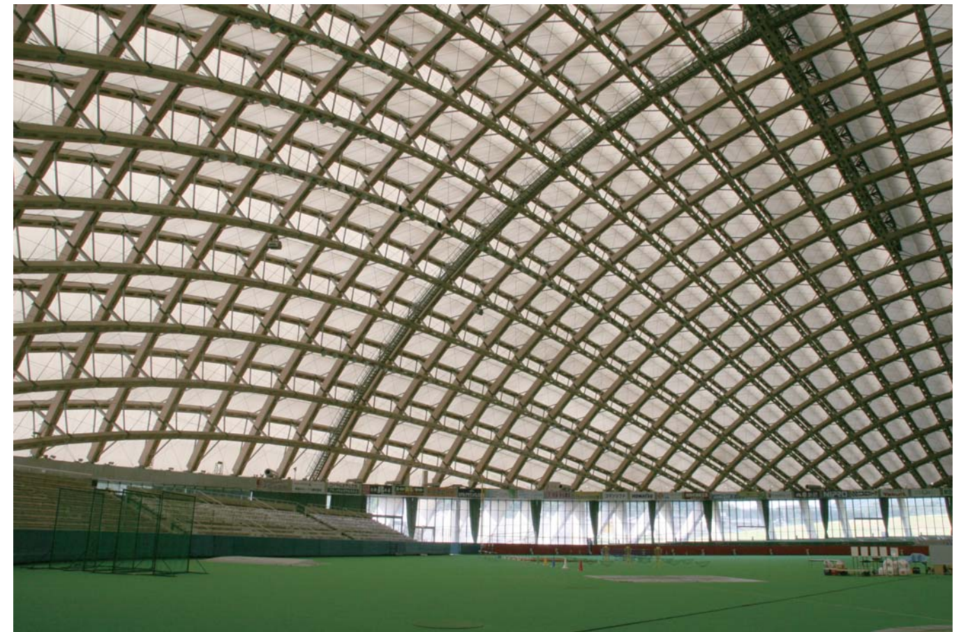
写真-2 大館樹海ドーム天井部分の構造
