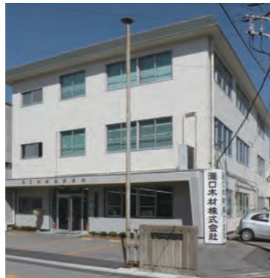
新木場1丁目の瀧口木材（株）の本社屋
