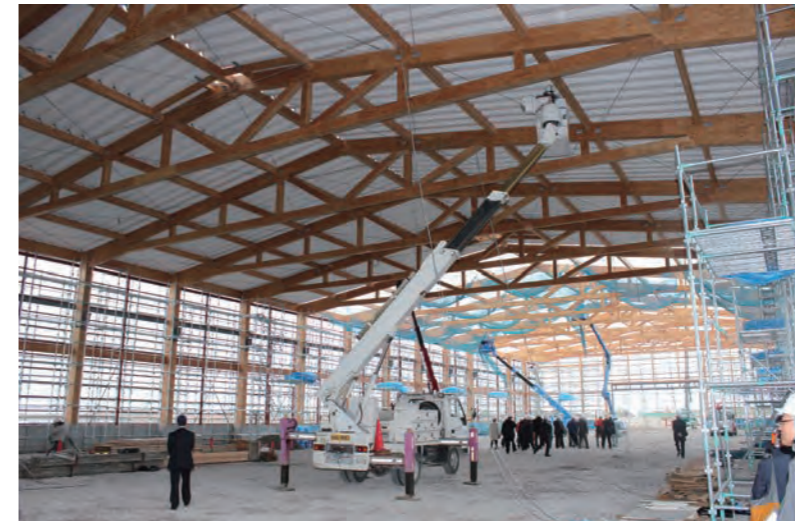
写真10 建築中の新工場。間口30m、桁行100mの木造最大面積。木造独特の温もりも
