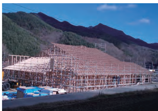
写真7 建築中の南相木村高齢者支援施設。3月竣工予定
