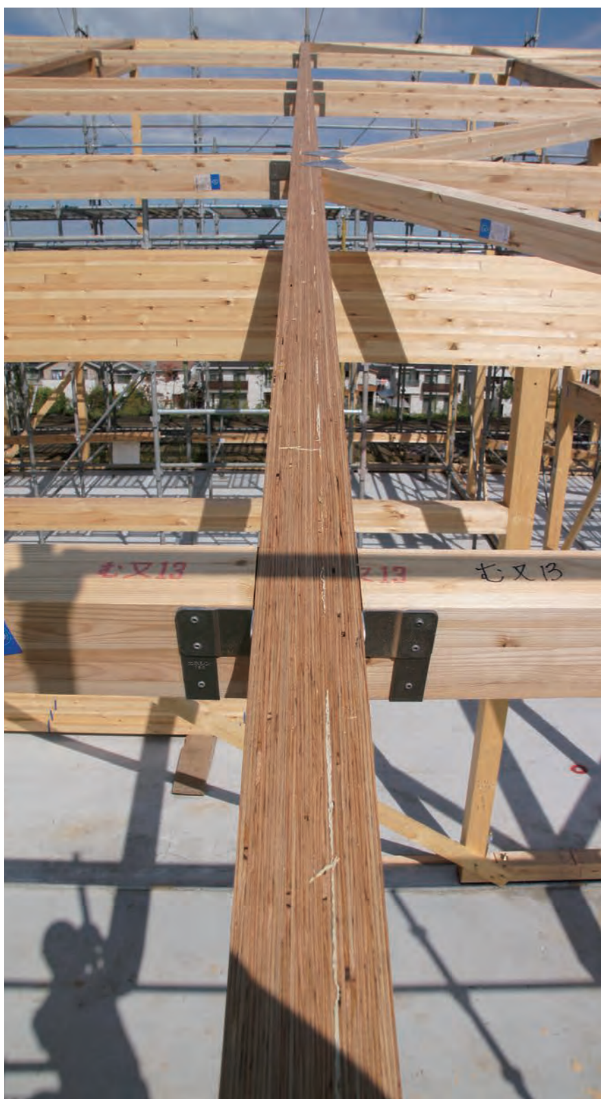
写真3 ロングスパンの長尺梁「キーラムメガビーム」
