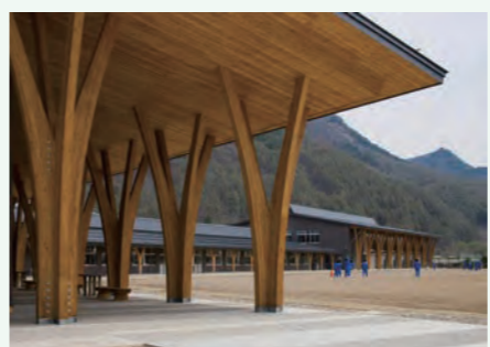
原生林をイメージした柱、「美林」。耐震力を高めるため集成材を利用している。この集成材は川上に残るカラマツの原生林と松葉をイメージしている
