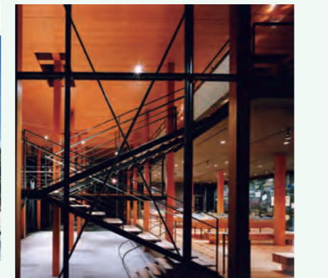
センター内のLVLを使用した柱
