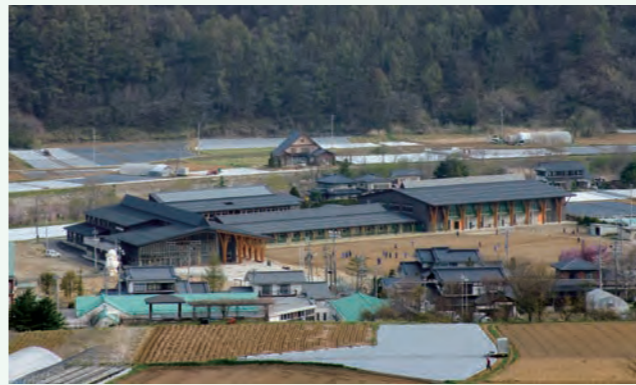
川上村の山懐に抱かれるように建つ、川上村立川上中学校。普通教室棟には、エコスクールとして、太陽熱を利用した暖房システム、パッシブソーラーシステムを備える
