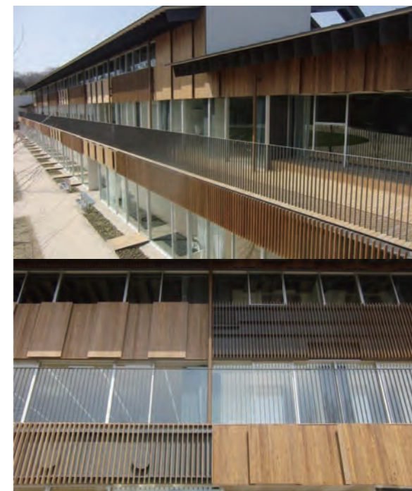
九州大学伊都ゲストハウス(内装、腰壁)
