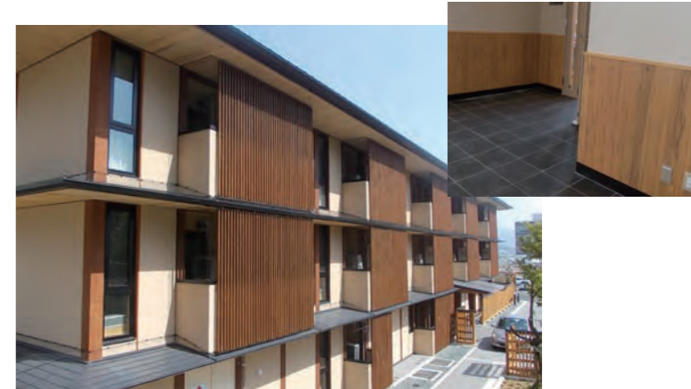
帝京大学八王子小学校(難燃(一部))
