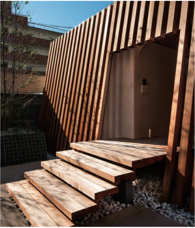
玄関の外階段は厚さ80ミリの一枚板のレッドシダー
