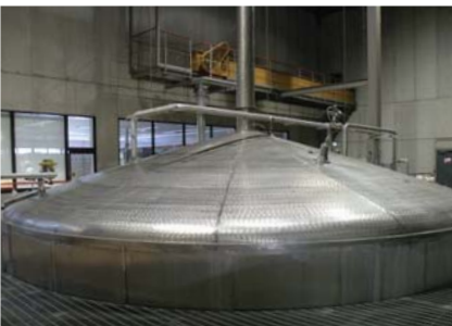
麦汁をつくる糖化槽。ここからポットスチルまで熱気のコもる建屋が続きます
