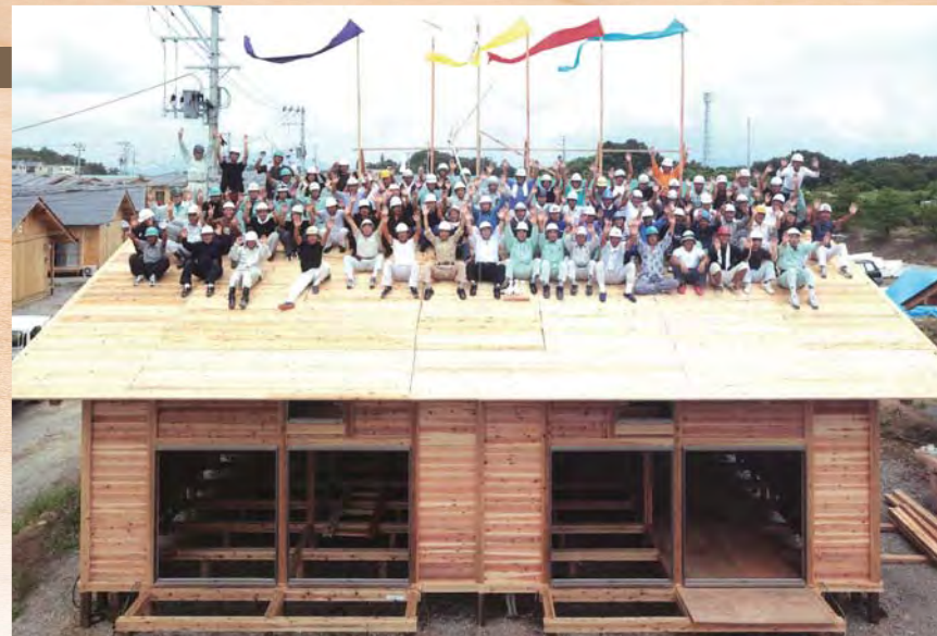
上棟式の記念写真。このとき建設にかかわった大工さん、スタッフが屋根に上った。（冊子「板倉の仮設住宅建設の記録」より）
