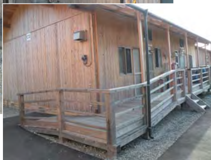
車椅子で利用できるスロープを配した玄関ポーチ
