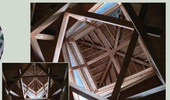
作業室に自然光を取り入れる天窓の架構を下から望む。(表紙写真参照)
