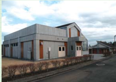
遺伝子組換え実験棟 遺伝子組換えを行う「実験室」、遺伝子組換え林木を外部から封じ込めて栽培する「閉鎖系温室」などを備える。
