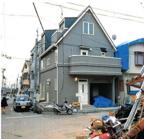
阪神淡路大震災に耐えたツーバイフォー住宅（提供：三井ホーム）
