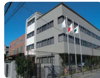
新木場1丁目の東京港湾事務所庁舎
