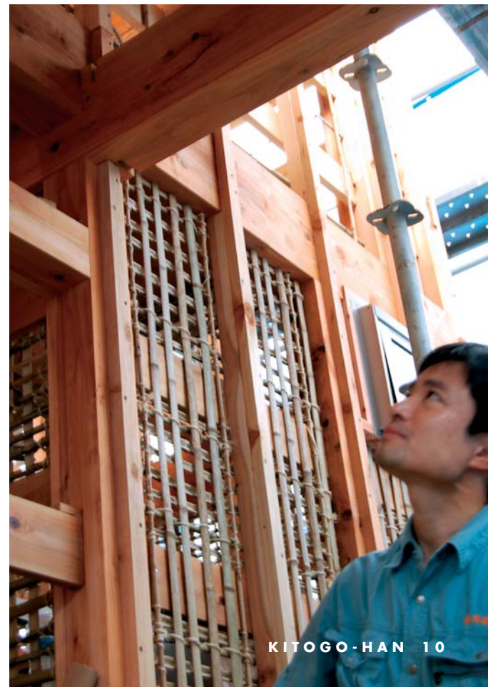
土壁の下地の竹が組まれたところ。このままでも見事で美しい表情を見せている。
