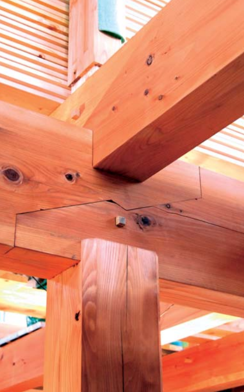
台持継手の接合部
