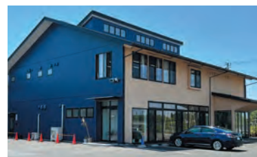
本社棟(北東側)
