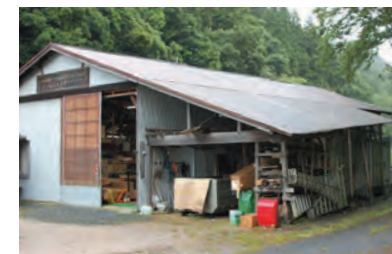
Ton-ton木工家具製作工房の作業所
