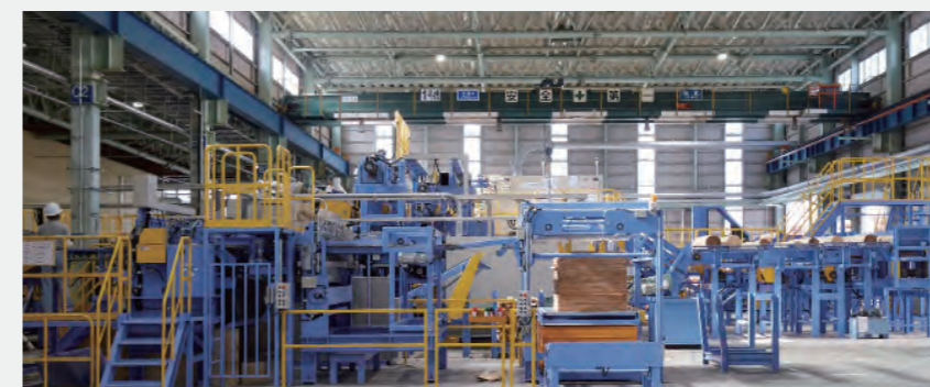
写真7 山梨工場(針葉樹合板製造)
