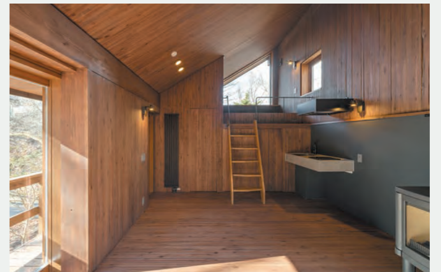
写真15 DLTHUT (設計: S.O.Y. 建築環境研究所)。屋根、壁、床に DLT を活用した小住宅。
