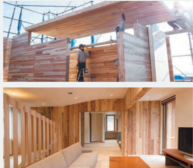
写真3 CLT パネルによる施工
