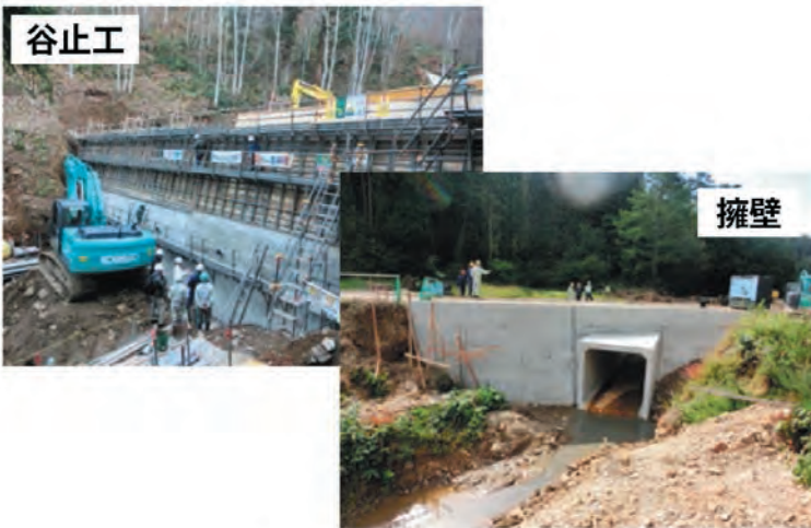
土木工事(左：谷止工、右：擁壁)での使用状況
