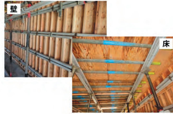
建築物(左：壁、右：床)での使用状況
