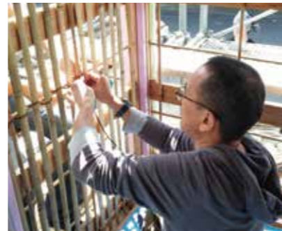
土壁ワークショップ 竹小舞土壁の和室現場 伝統技術に触れる授業で 小舞掻きと土壁塗りに挑戦
