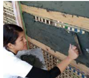
土壁ワークショップ 竹小舞土壁の和室現場 伝統技術に触れる授業で 小舞掻きと土壁塗りに挑戦
