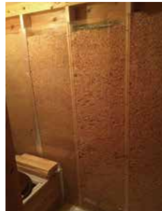
おが屑断熱材の実験 おが屑を壁内に再利用する取組み
